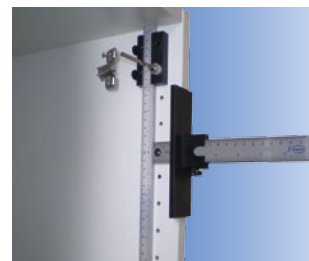
Taladrado para la colocación de bisagras invisibles.
