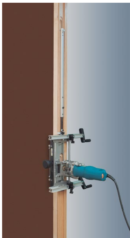
Realización del segundo encaje en el marco.
