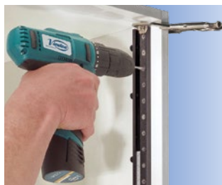
Taladrado para la colocación de estantes.
